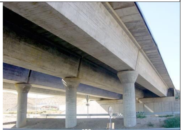
Puente sobre lecho de río para autovía. Valencia
