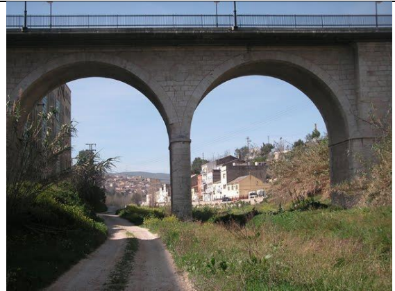
Puente sobre el Clariano. Pont Nou. Ontinyent
