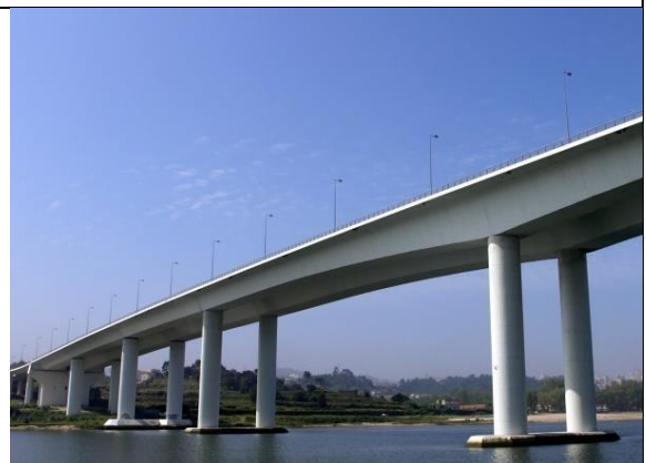
Puente del Freixo. Oporto (Portugal)
