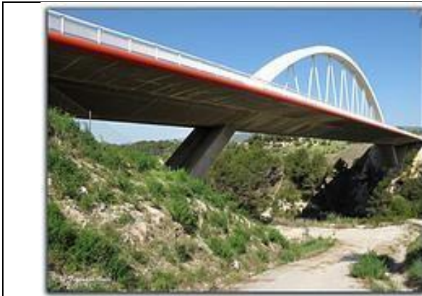
Puente sobre el río Clariano. Salt del Bou. Ontinyent
