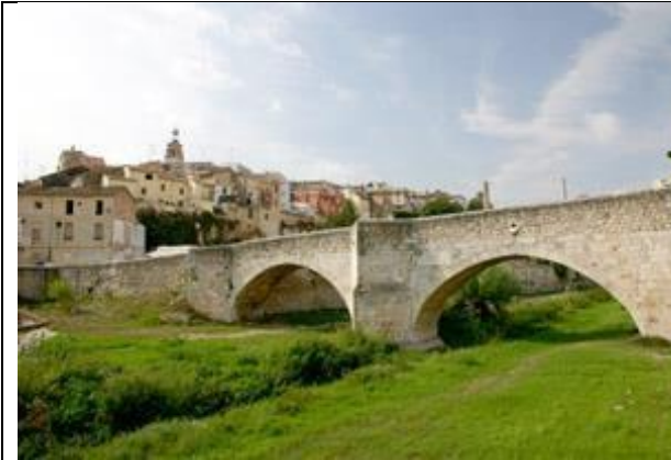
Puente sobre el río Clariano. Pont vell. Ontinyent
